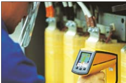
Inspección del transformador
